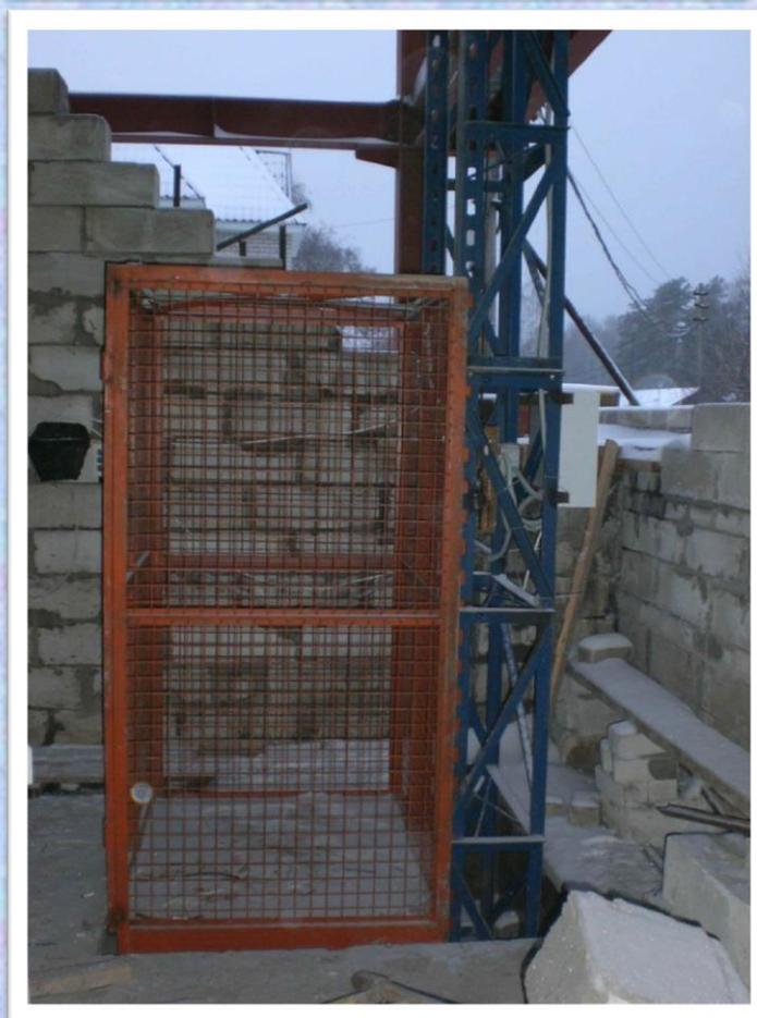
*Управление подъемником осуществляется с помощью кнопочных постов управления (КПУ), расположенных на каждом этаже на самонесущей мачте или не далее 5 м. от нее. КПУ имеют кнопки со световой индикацией, а так же аварийную кнопку СТОП.*
