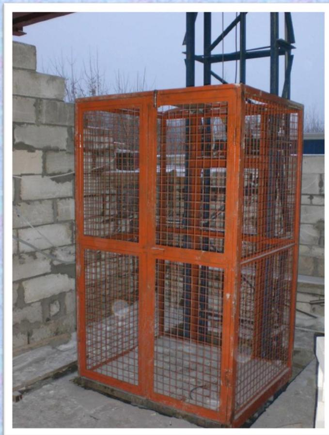
*Мачтовый подъемник Ск-ПМ может устанавливаться как снаружи здания, так и внутри здания (в проемах межэтажных перекрытий или в готовую лифтовую шахту)*
