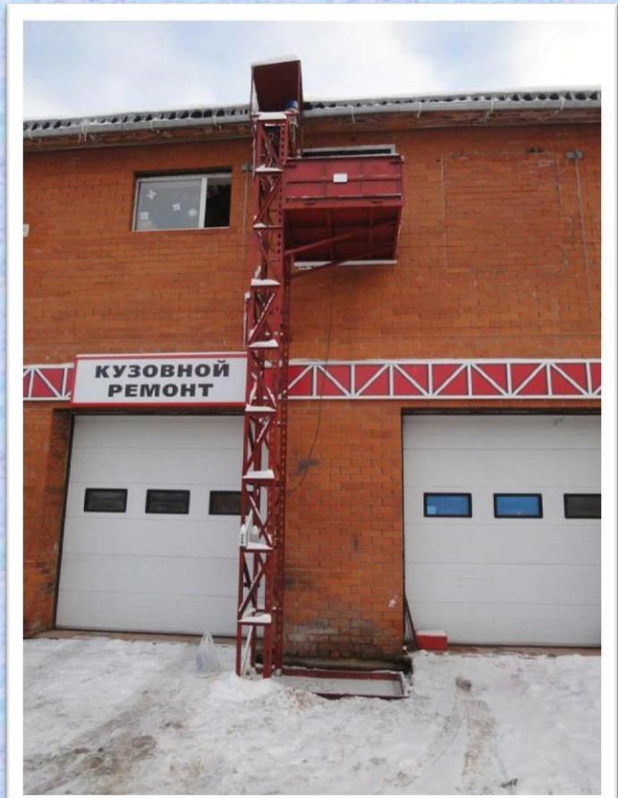
*Отличие подъемников мачтового типа от шахтного подъемника (грузового лифта) – быстрые сроки изготовления, простота монтажа, более низкая стоимость по сравнению с шахтными подъемниками.*
